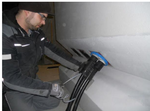
Abb.4: Herausziehen der Plastikspirale
