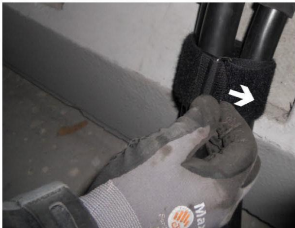
Abb.13: Den Gurt durch den Metallbügel fädeln
