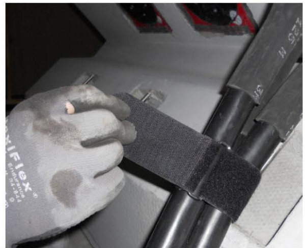
Abb.16: Umschlagen des Gurtes zum fixieren
