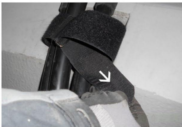
Abb.9: Retourfädeln des Klettkabelgurtes
