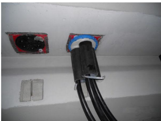
Abb.3: Einführen der abgehenden Kabel
