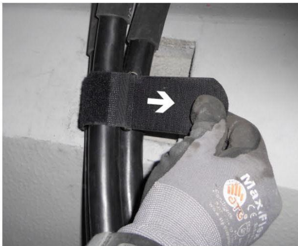
Abb.15: Festziehen des Klettkabelgurtes
