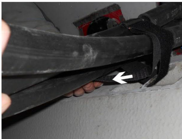
Abb.11: Durchziehen des Gurtes unter den Kabeln
