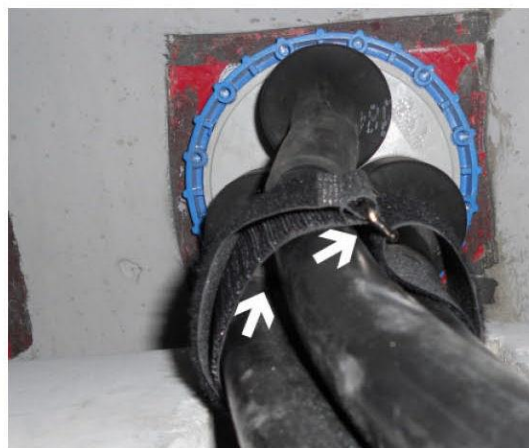
Abb.12: Weiter fädeln des Gurtes zum Metallbügel
