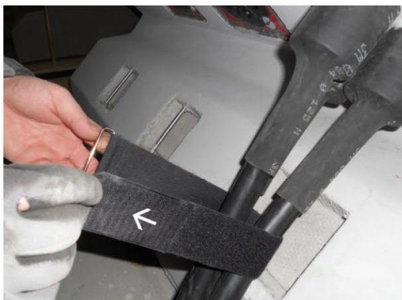
Abb.7: Durchziehen des Kabelgurtes
