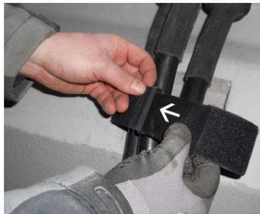
Abb.8: Einfädeln in den Metallbügel
