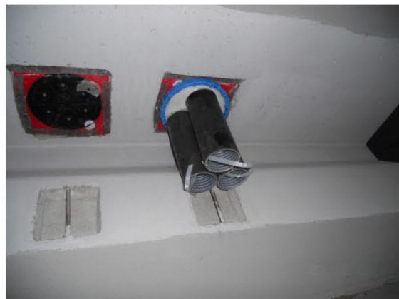
Abb.2: Aufstecken der Kaltschrumpfschläuche
