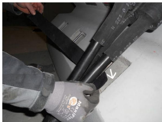
Abb.6: Durchfädeln des Klettkabelgurt
